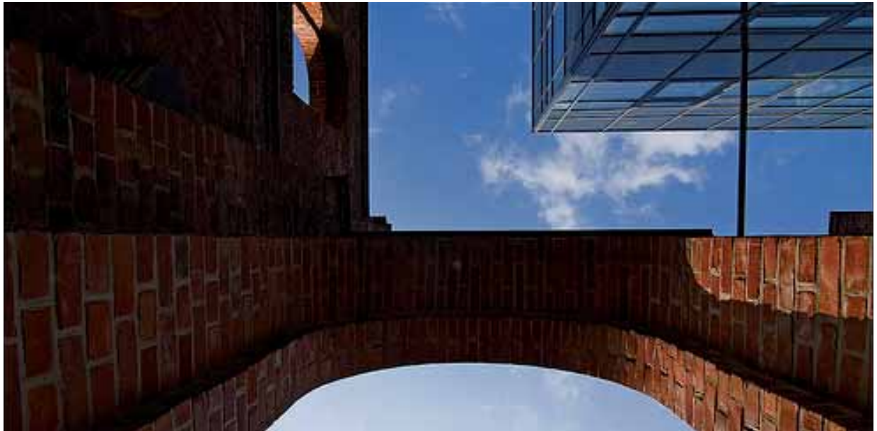
Oben: Abb. 19: Detail des Sophie-Henschel-Hauses: Die alten Ziegelsteinmauern der Werkhalle K13 kontrastieren bewußt mit der modernen Glasfassade des Universitätsgebäudes.
