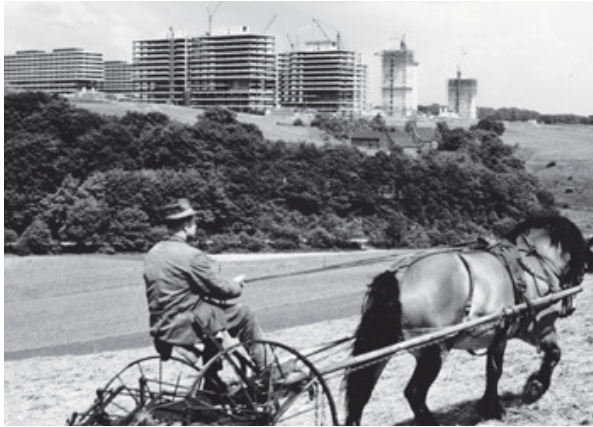
Oben: Abb. 12: Die Anfang der 1960er Jahre gegründete Bochumer Ruhr-Universität: Zunächst musterhaftes Beispiel moderner Hochschularchitektur, bereits ein Jahrzehnt später das Negativbeispiel einer „Beton-Uni“.
